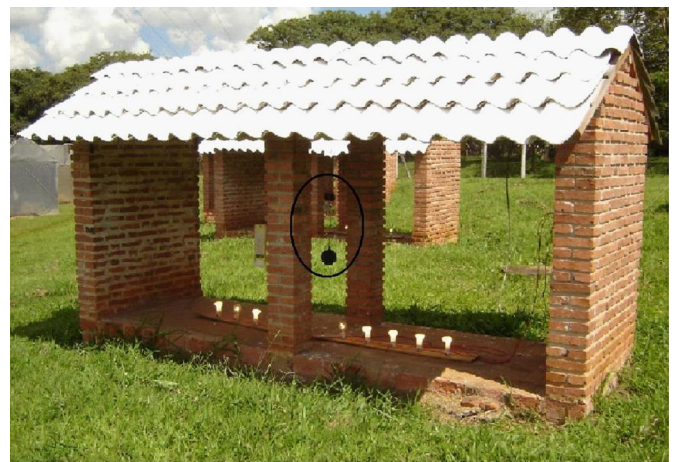
Figura 1. Vista do protótipo e localização do mini datalogger
