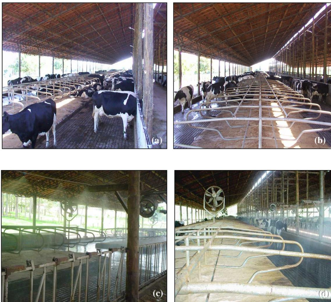
Figura 7 - Vista do *freestall* antes (a, b) e após (c, d) a implantação do sistema de resfriamento
