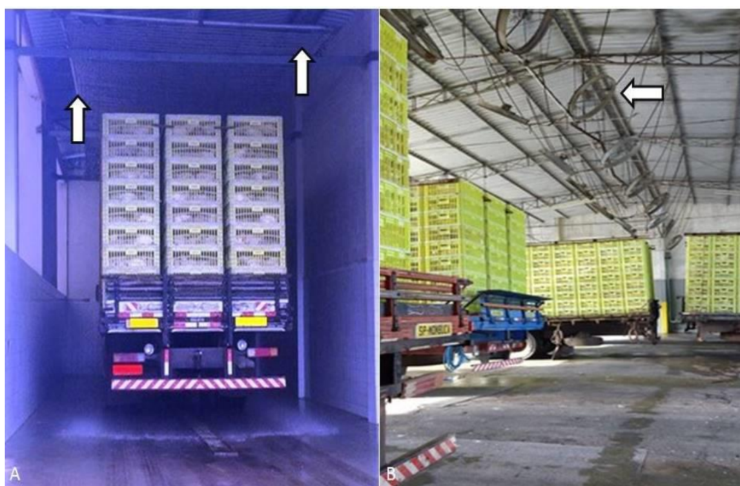
Figura 7. Evidenciação do sistema de tubos da ducha e dos ventiladores e aspersores na sala de espera.
