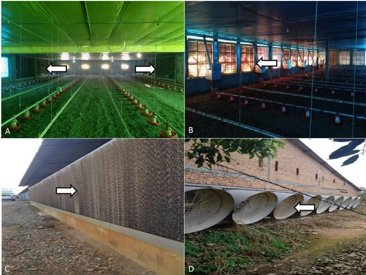
Figura 3. Galpões de pressão negativa. Evidenciação das placas evaporativas (A) e dos exaustores (B), segundo vista interna do galpão e, das placas evaporativas (C) e dos exaustores (D), segundo vista externa do galpão.
