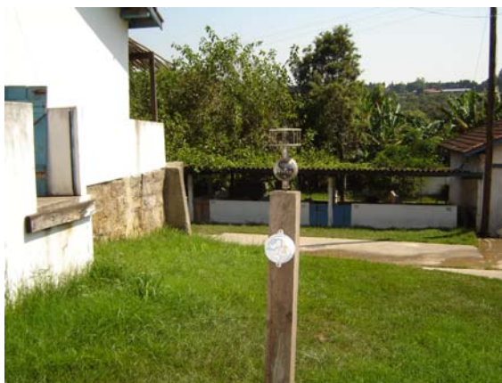
Figura 3 - Anemômetro e microprocessador blindado instalados no ambiente externo à instalação
