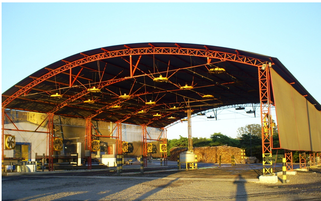
Figura 18 - Galpão de espera do abatedouro comercial de frangos de corte
