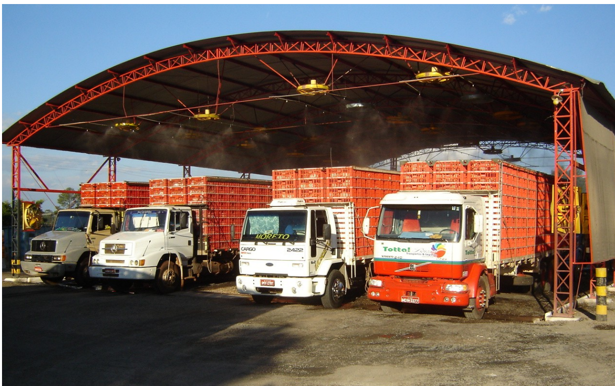
Figura 19 - Vista frontal da sala de espera com os caminhões estacionados
